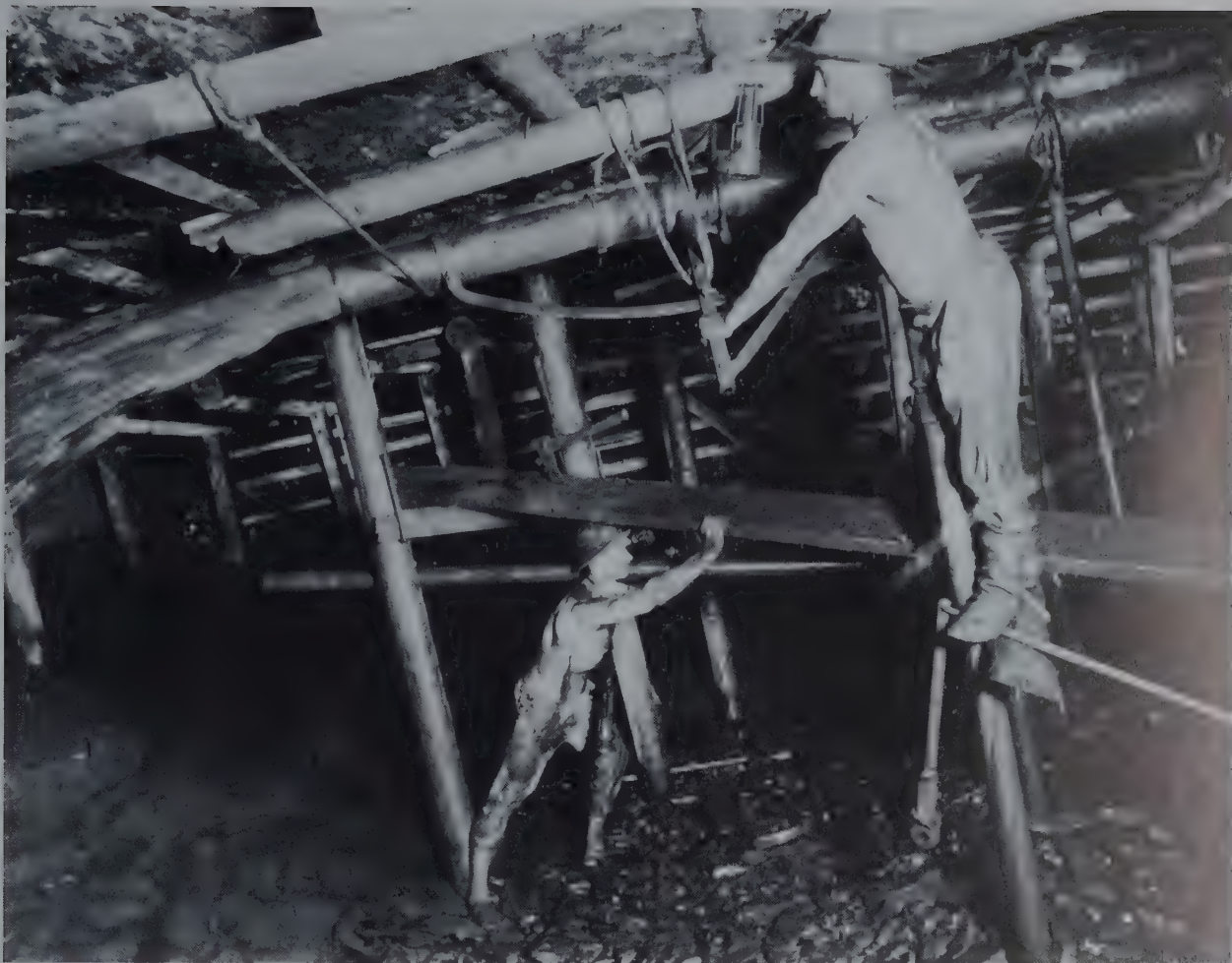
Bergleute beim Einbringen von Spülversatz in halbteiler Lagerung, um 1910
