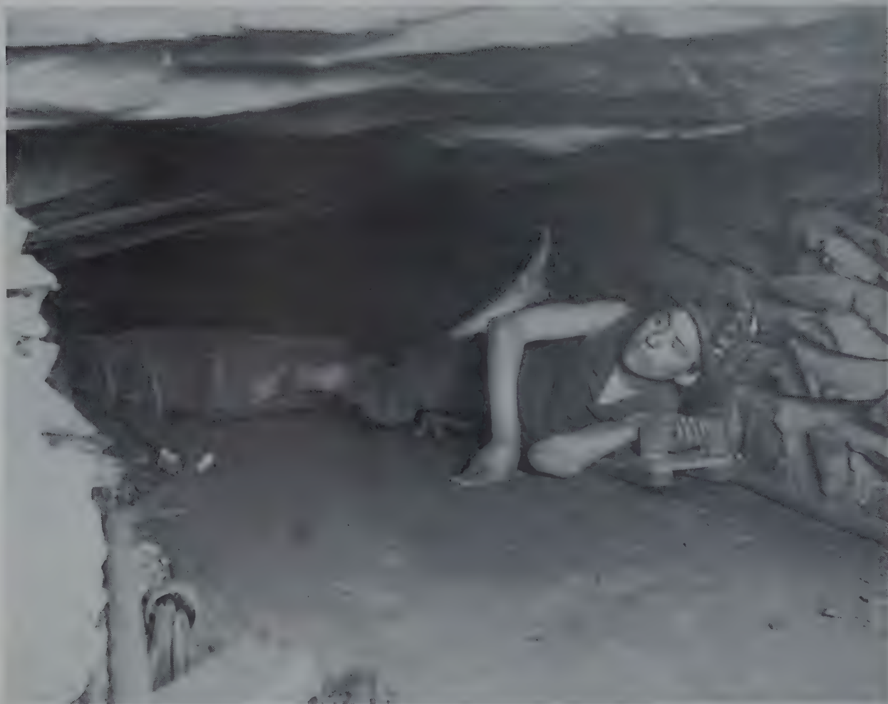
Bergmann mit Achselbrett bei der Streckenförderung im Mansfelder Kupferschieferbergbau, um 1920
