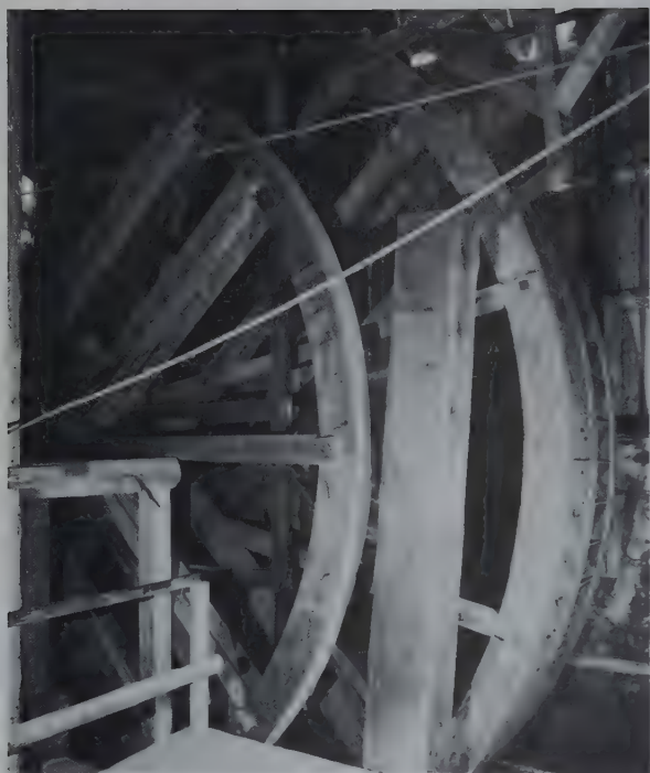
St. Andreasberg, Grube Samson, Kehrrad mit Bremsscheibe
